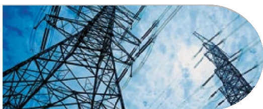
TRANSMISIE ȘI DISTRIBUȚIE DE ENERGIE
